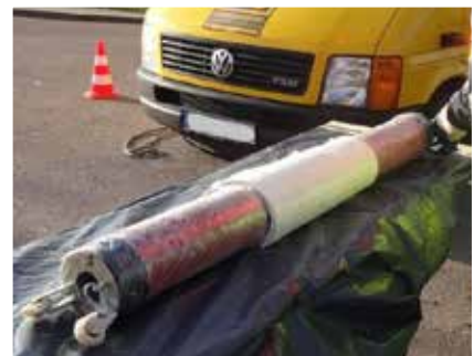
Packer mit Kurzlinerlaminat
