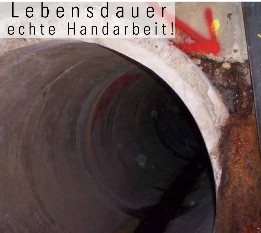
Grundwassereintritt Schachtanbindung
