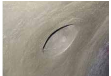
Stutzen nach der Sanierung
