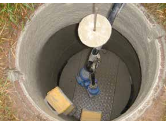
Schachtbeschichtung im Schleuderverfahren
