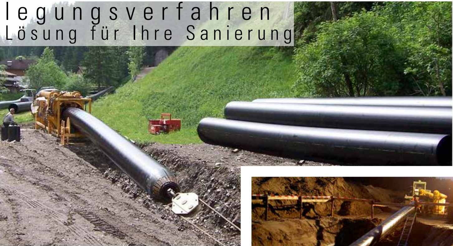
DynTec-Rig und Rohrstrang
