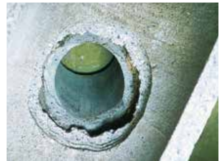
vorgefräster Stutzen vor der Robotersanierung
