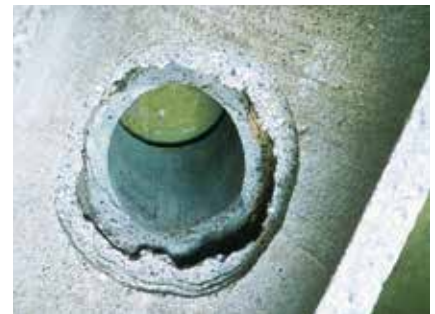
vorgefräster Stutzen vor der Robotersanierung
