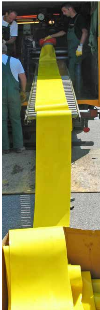
Der Liner wird zur Zwei-Komponenten Harzfüllung auf dem Förderband vorbereitet
