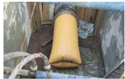
Der Liner kommt am Rohrende an
