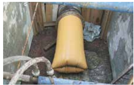
Der Liner kommt am Rohrende an
