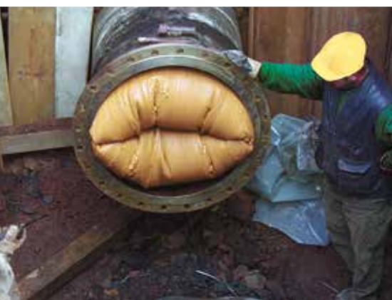
Der Sanflex®-Liner DN 700 kommt am Rohrende an
