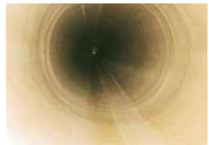
fertiggestellter Liner nach der TV-Befahrung
