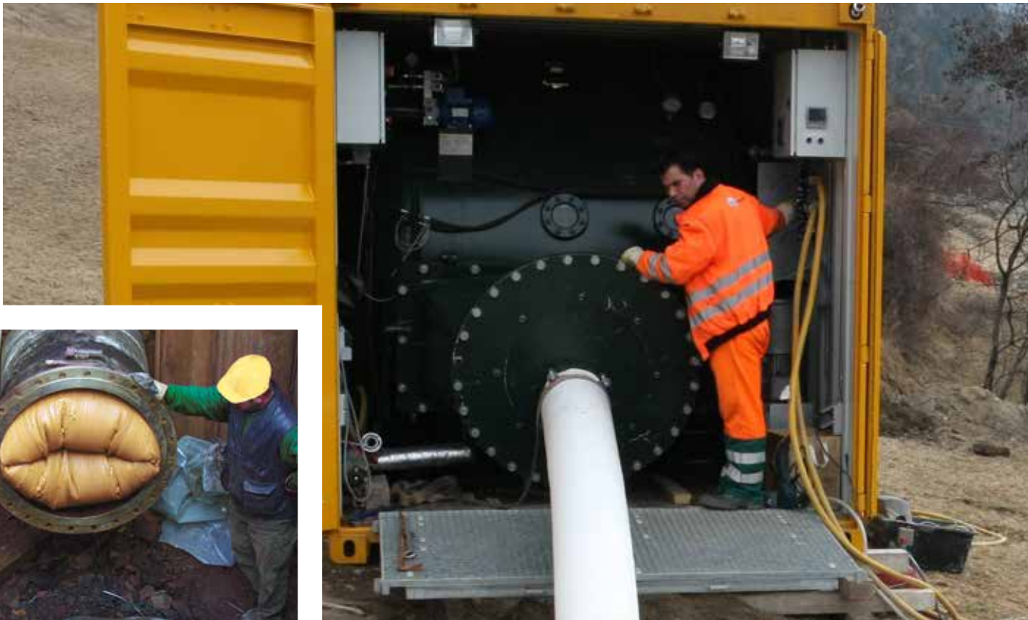
Der Sanflex®-Liner DN 700 kommt am Rohrende an
