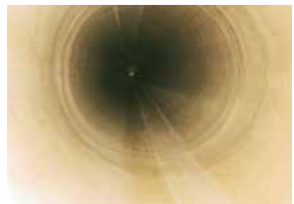
fertiggestellter Liner nach der TV-Befahrung
