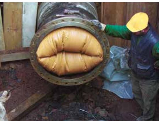
Der Sanflex®-Liner DN 700 kommt am Rohrende an
