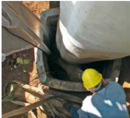
Einführen des Schlauchliners in das Eiprofil
