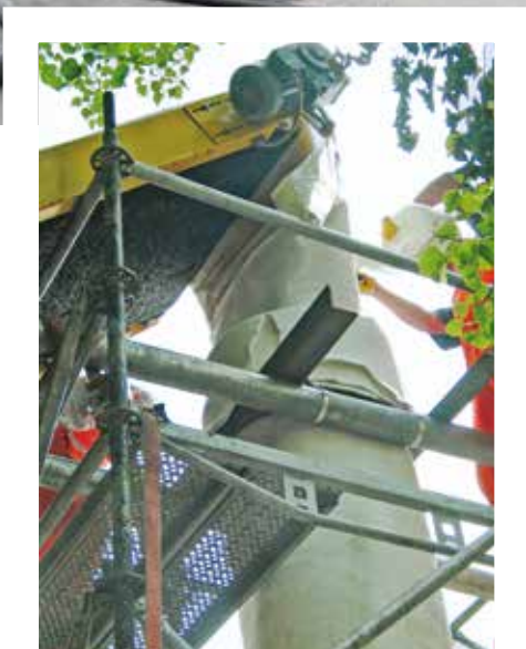
Über den Inversionsturm wird der Inliner in die Haltung eingebracht.
