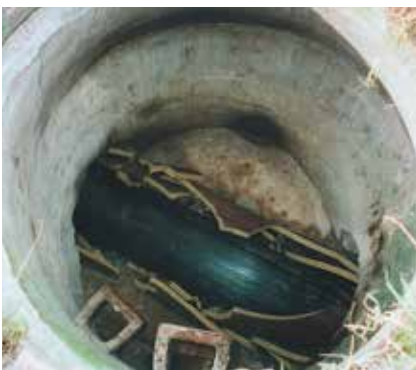
eingezogenes Neurohr im Schacht
