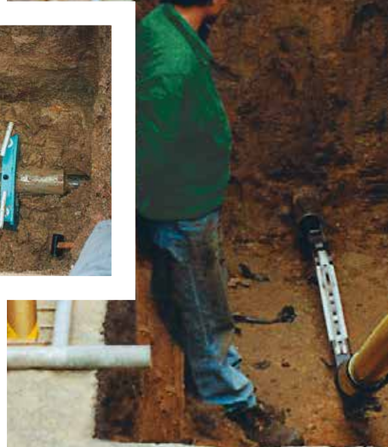
Einziehgrube mit PE-Rohrstrang
