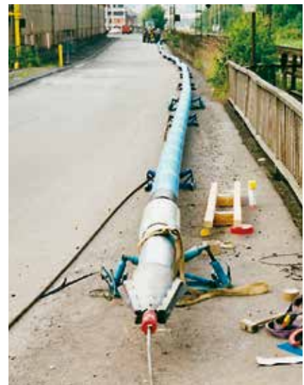
Rohrstrang mit Schneidkopf
