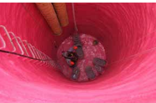
Réhabilitation d'un regard de pompage
