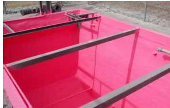
Sanierung eines Absatzbeckens
