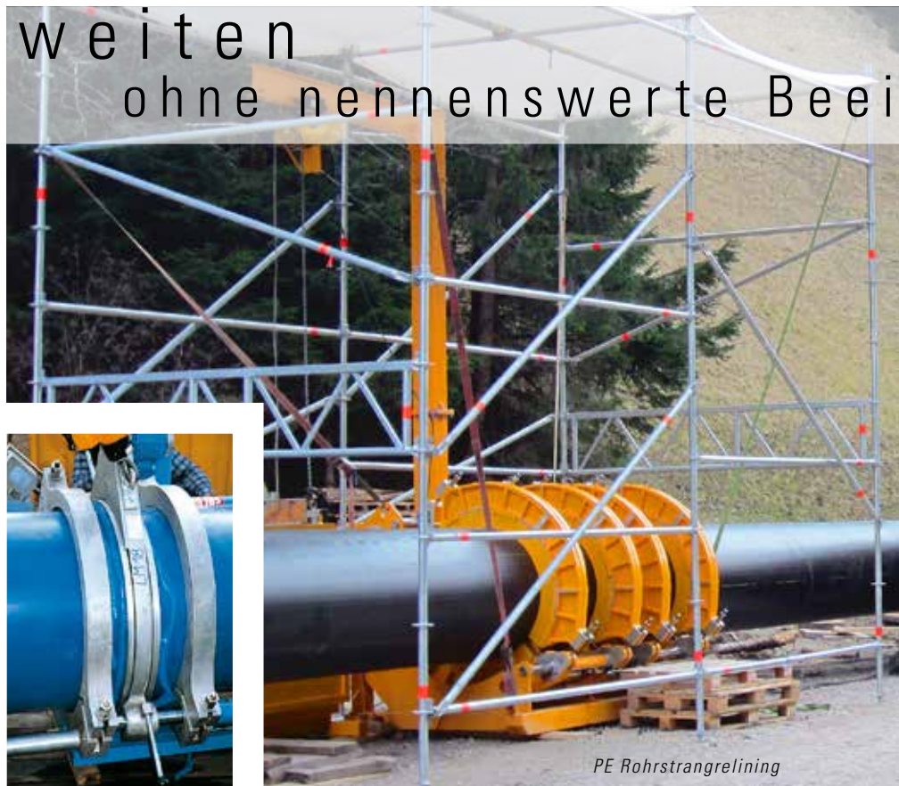
PE-Stumpfschweißgerät
