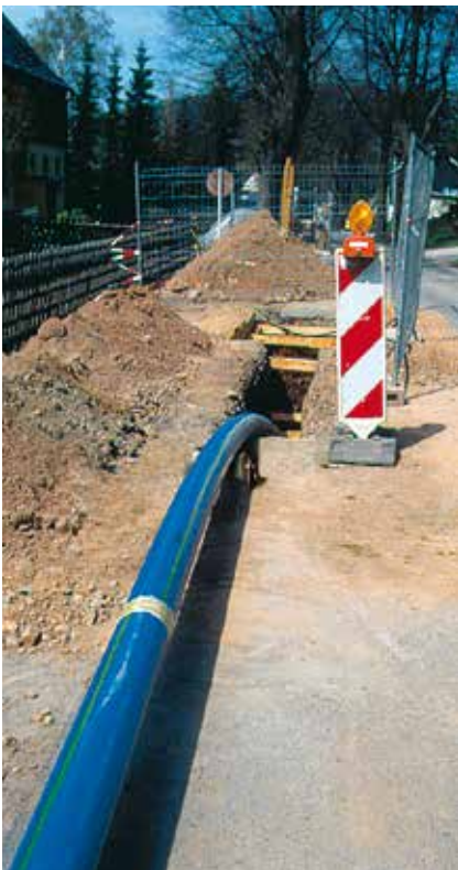
Einziehgrube PE Relining DN 300
