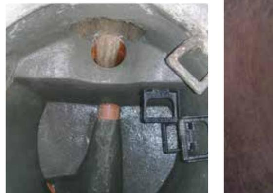
Abgedichteter und sanierter Schacht mit Absturz
