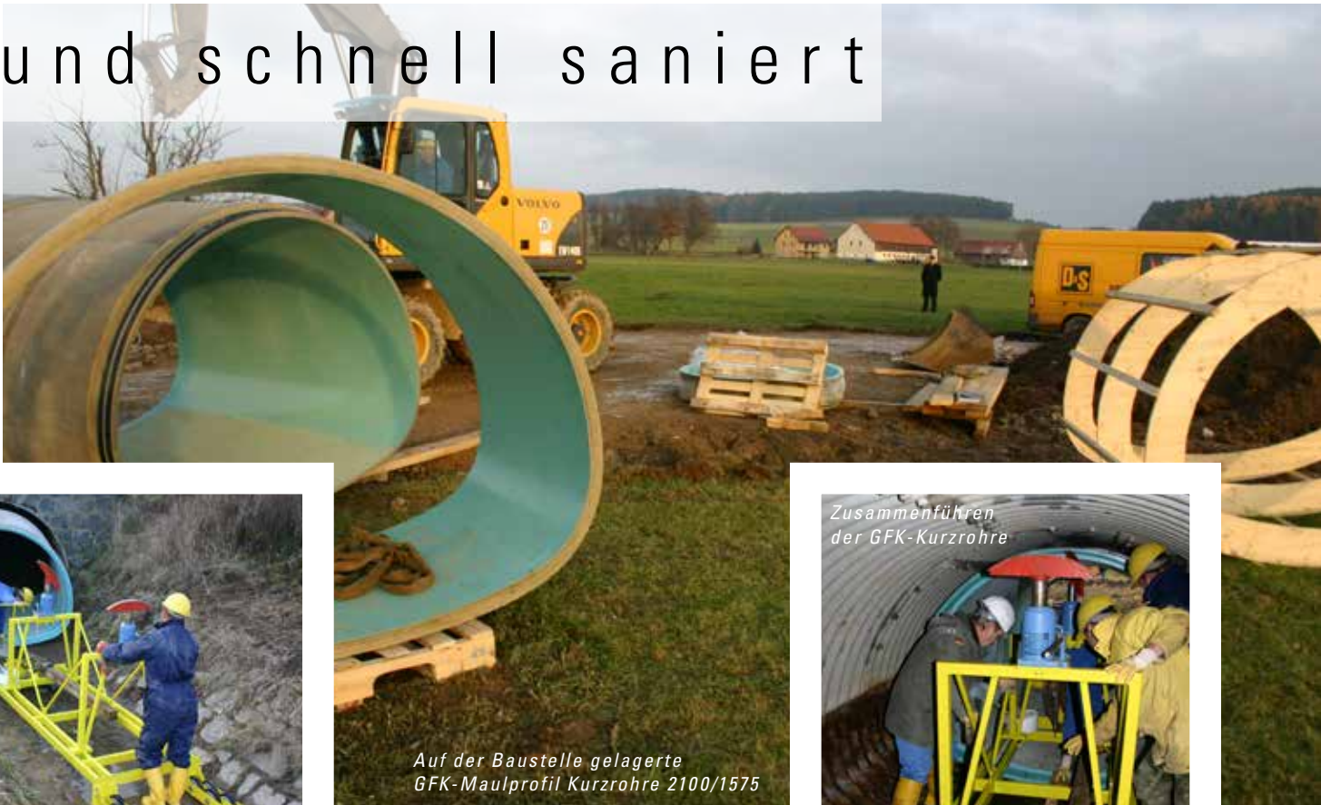
Positionieren des Rohrwagens zum Aufnehmen des Reliningprofils
