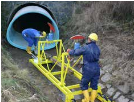
Positionieren des Rohrwagens zum Aufnehmen des Reliningprofils
