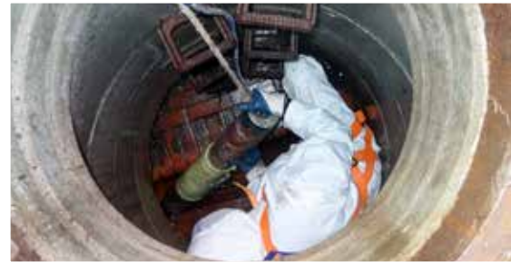
Kurzlinerpacker wird eingesetzt
