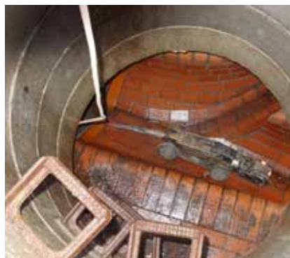
TV-Überwachung Kurzliner-Einbau
