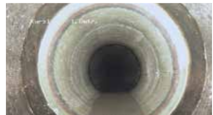
Schadstelle mit Kurzliner saniert
