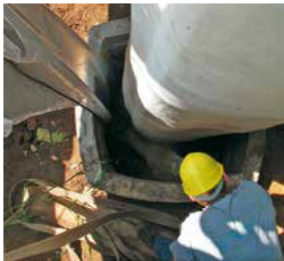
Einführen des Schlauchliners in das Eiprofil
