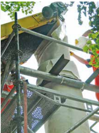
Über den Inversionsturm wird der Inliner in die Haltung eingebracht.
