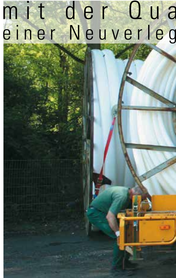
Das Compact Pipe Rohr wird mit der verfahrenstypischen Verformung eingezogen
