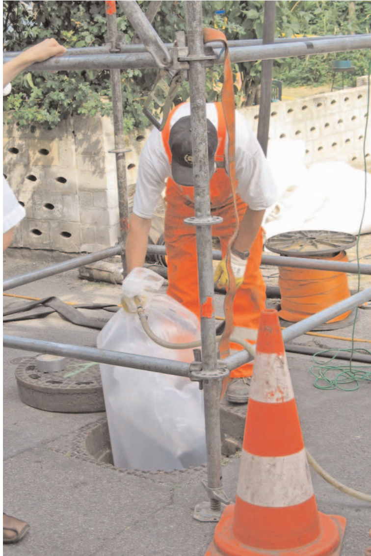
Vorbereitung des Preliners.
